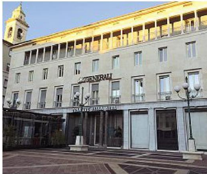
In centro Rivoluzione a pianterreno dell'edificio di piazza Libertà 10
